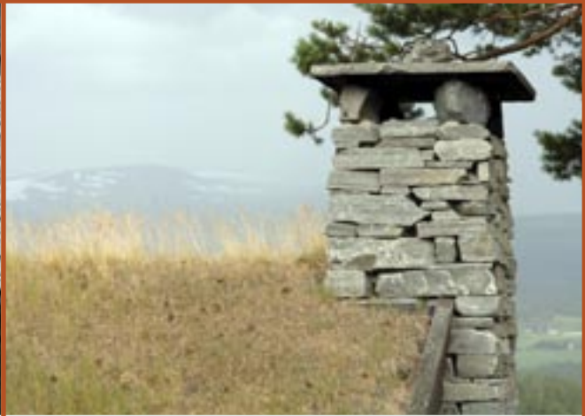
Pipe med tørrmur og pipehelle i Oppdalskifer.
