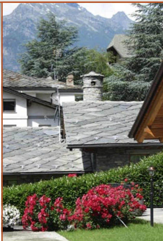
Tak (Italia) med bruddheller i Oppdalskifer.
